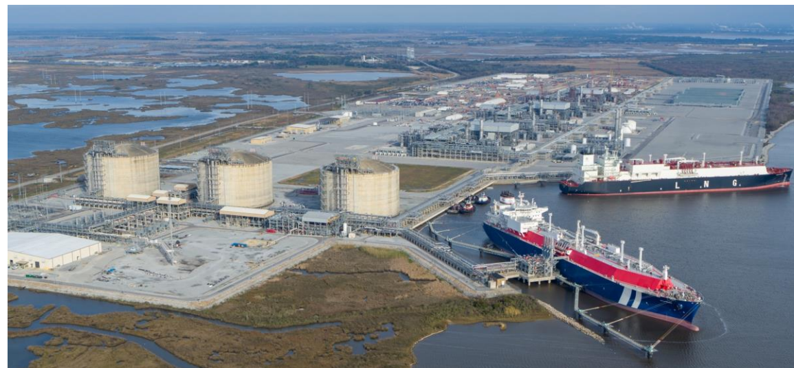
Loading at Cameron LNG
